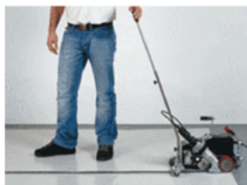
ZGRZEWANIE ZAKŁADEK
